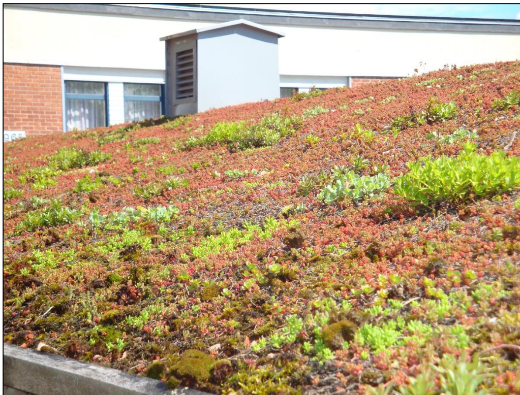
Figur 15. Exempelbild på ett grönt tak med sedumsväxter (Foto: Sweco).
