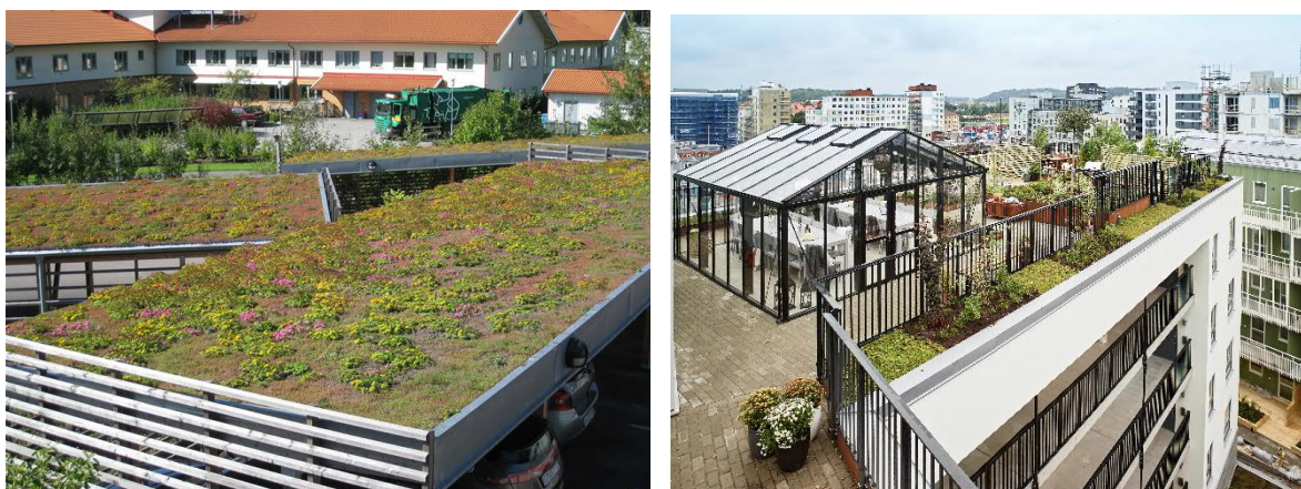
Figur 22. Grönt sedumtak på garagebyggnad, samt bostadshus med gröna inslag på takterrass. Bildkälla: VegTech AB samt Veidekke AB.
