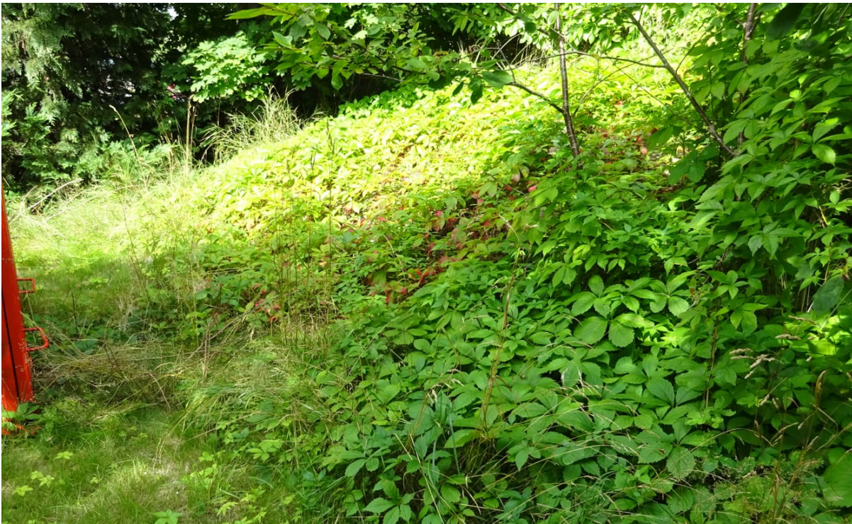
Bild 15 på terrängen där man ser en slänt, men tittar man närmare så ser man att det även där finns ytligt berg under vegetationen. Den lutande terrängen inom detaljplaneområdet innebär ytligt berg (med lokalt påförd fyllning). Detta innebär att inga stabilitetsproblem föreligger.
