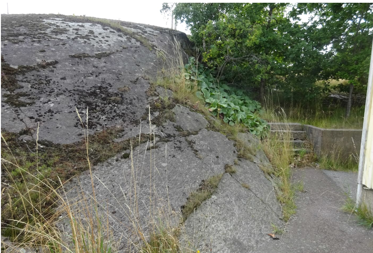
Bild 12 på berget tagen mot söder där man ser begränsat antal sprickor i massivt berg och att husläget har anpassats till naturligt berg utan sprängning. En mindre betongmur har anlagts för att ta upp mindre nivåskillnad.
