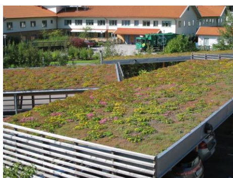
Figur 22. Grönt sedumtak på garagebyggnad i Kungsbacka. Bildkälla: VegTech AB.
