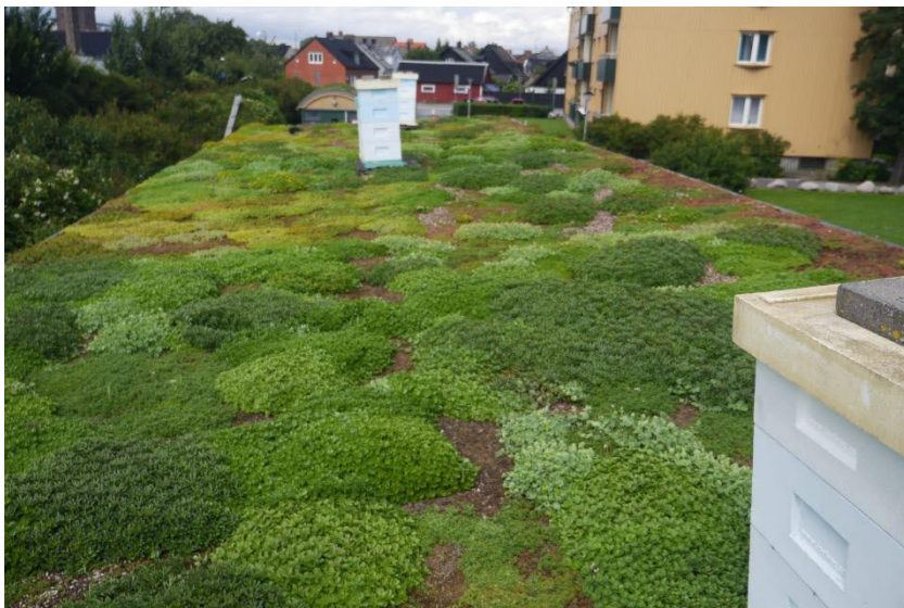
Figur 34. Grönt tak i stadsdelen Seved i Malmö. Foto: Jonathan Malmberg. Bildkälla: Boverket.
