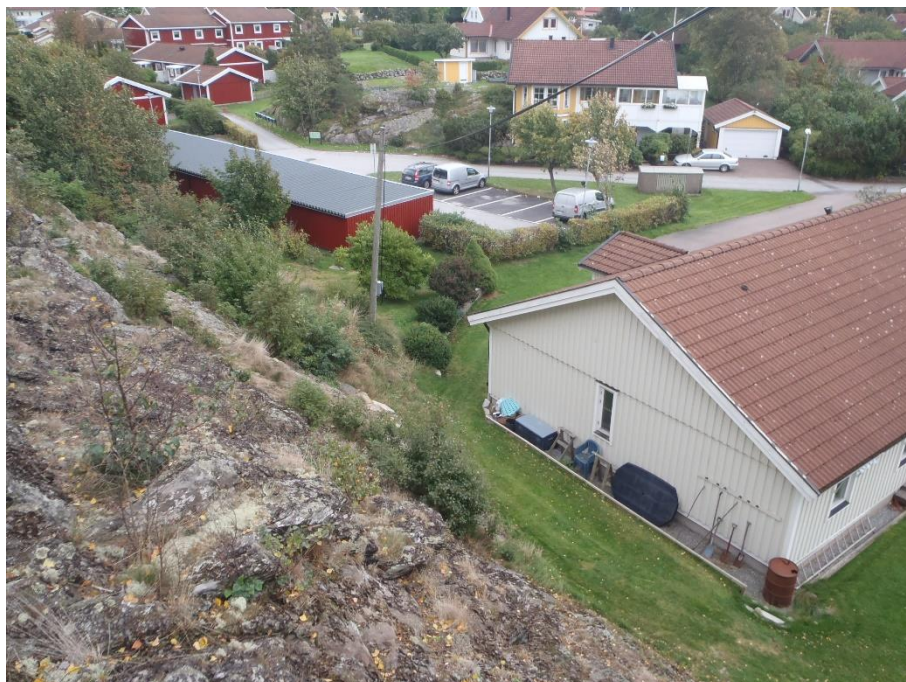
Figur 5. Den södra bergsbranten med befintliga fastigheter nedanför. Inga instabila eller utfallna block observerades i branten.
