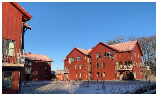
Nybyggt flerbostadshus längs Bagarevägen. Vy mot nordväst.
