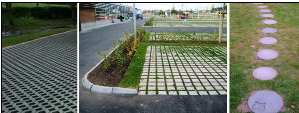
Figur 12. Ytor med hålsten av betong samt gångstig med gräs och gångplattor (Norconsult)
