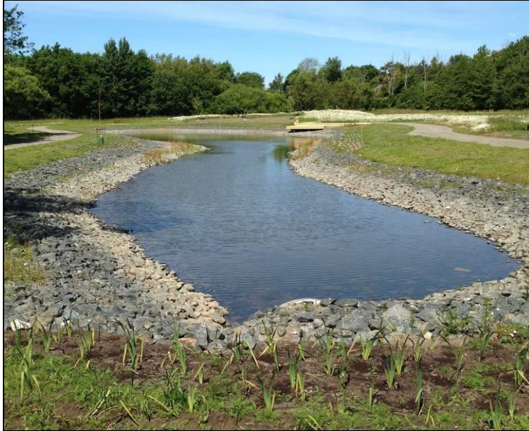
Figur 8. Exempel på dagvattendamm i Trönninge i Varberg (Norconsult)
