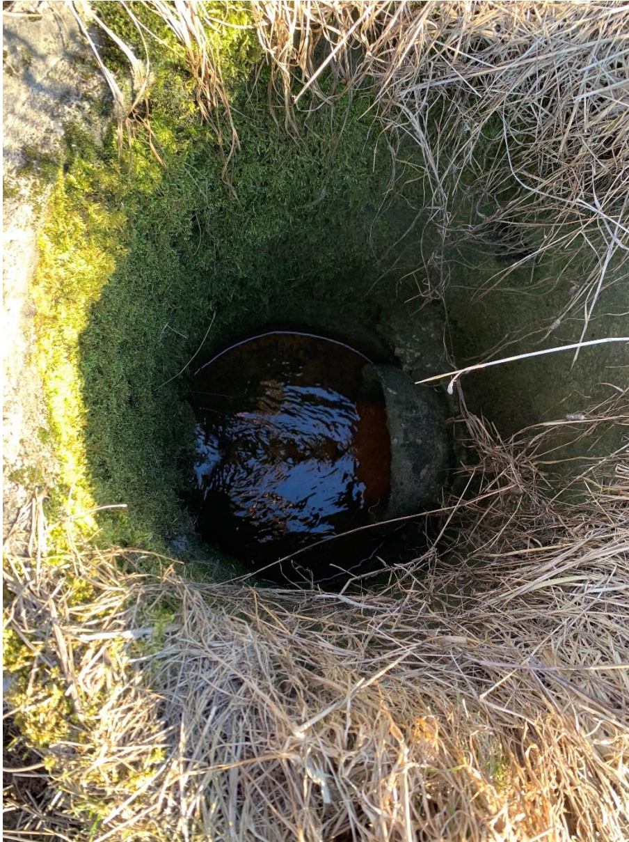
Figur 25 En av brunnarna som öppnades. Rinnande vatten kan ses i brunnen, djupet mer till vattenspegeln var ca 110 cm.
