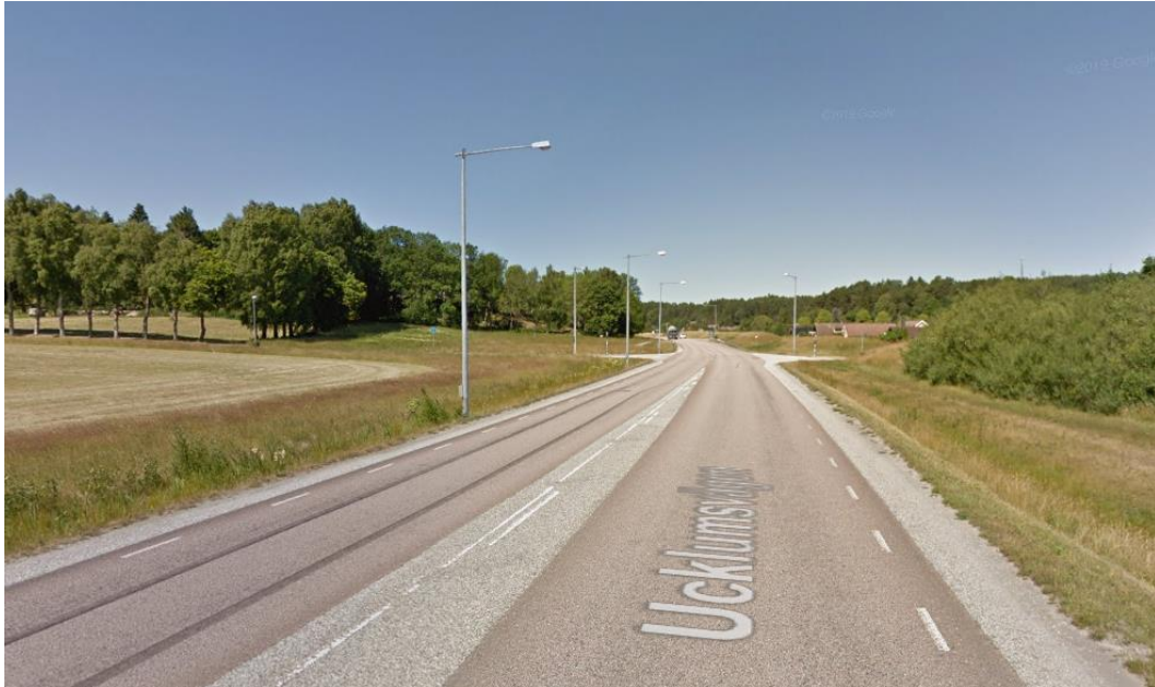
Figur 36 Ucklumsvägen mot norr, strax söder om Ärtvivelvägen.
