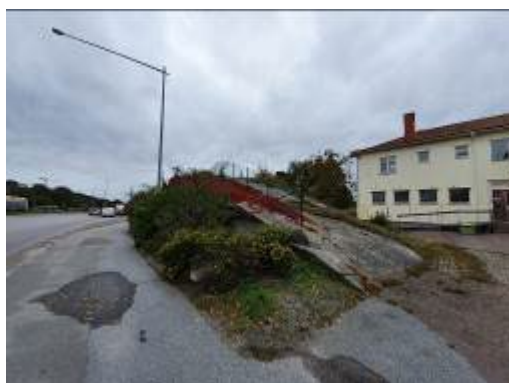
Snippenberget och Göteborgsvägen. Vy mot söder.
