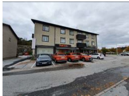
Parkeringsplatser på norra sidan av CW Borgs väg. Vy mot norr.
